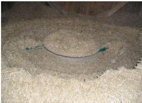
Aus dem Lagerraum (oben) wird der Miscanthus über eine Zuführschnecke (unten rechts im Bild) zur Heizung (unten Mitte) transportiert.
