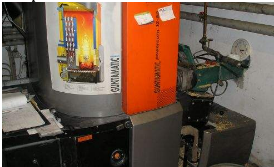
Aus dem Lagerraum (oben) wird der Miscanthus über eine Zuführschnecke (unten rechts im Bild) zur Heizung (unten Mitte) transportiert.
